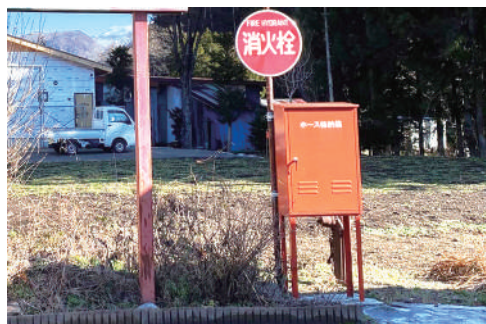
消防ホース格納庫
