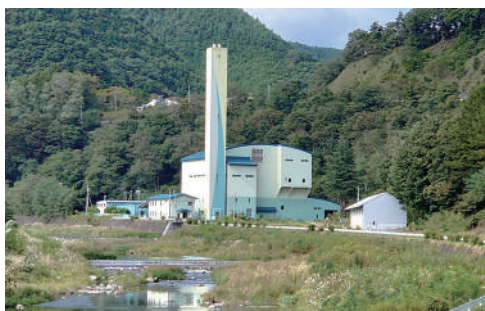
稼働中の尾瀬クリーンセンター
