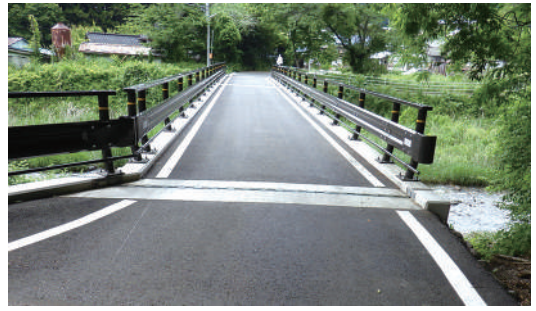
修繕された下小川橋（繰越事業）
