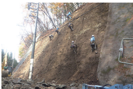
村道の法面吹付工事
