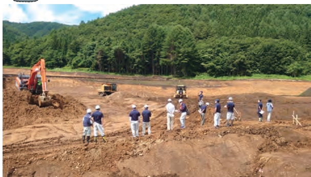
管内視察（牛の平基盤整備工事）
