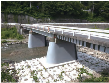
下部工の補修が済んだ学校橋
