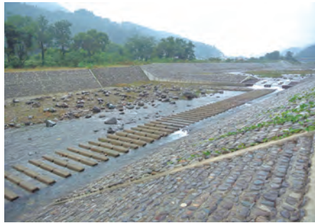
整備完成間近の越本地区の河川
