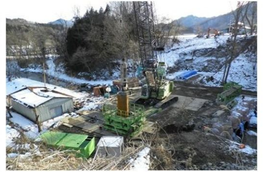
塗川橋架替工事(下部工) 大型機械による杭基礎工事
