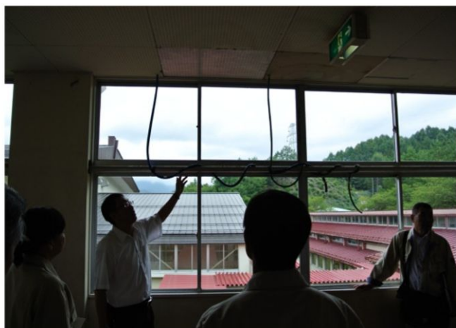
老朽化で、大規模改修となる片品中学校(内部)
