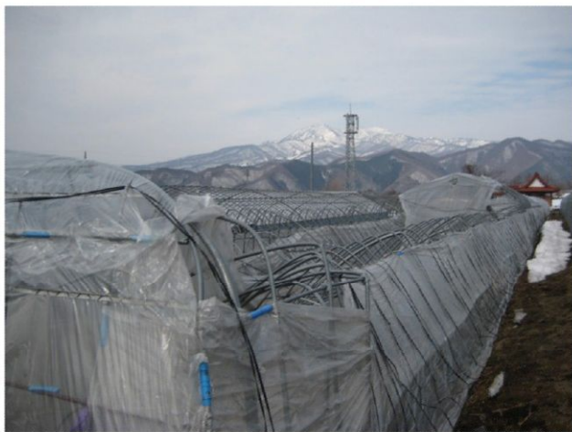
歴史的大雪により被害を被ったパイプハウス
