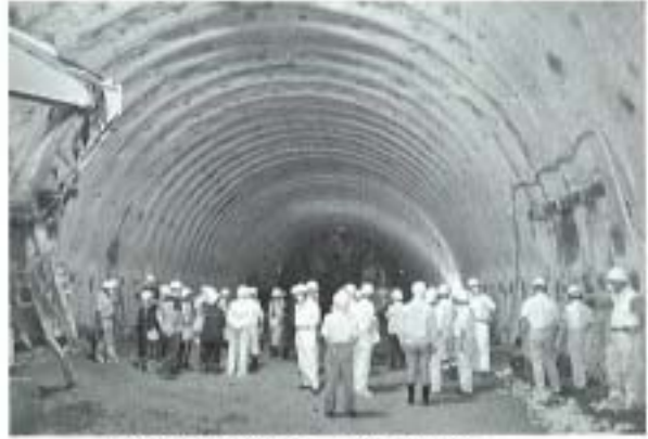
掘削中の権坂トンネル視察
