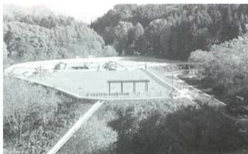
完成間近の尾瀬大橋下公園
