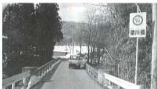
幡谷出入口の塗川橋
