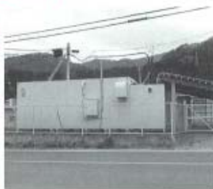
光ファイバー敷設となるNTT土出交換局
