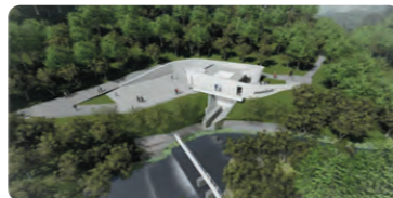
尾瀬片品発電所
