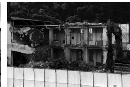
役場側の旧西校舎の解体作業。手作業で、屋根や窓枠を外した後、大型の重機で建物を崩していく様子。
