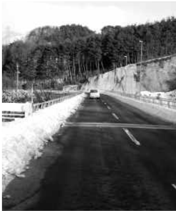
橋の上は路面状態が悪いことが多い
